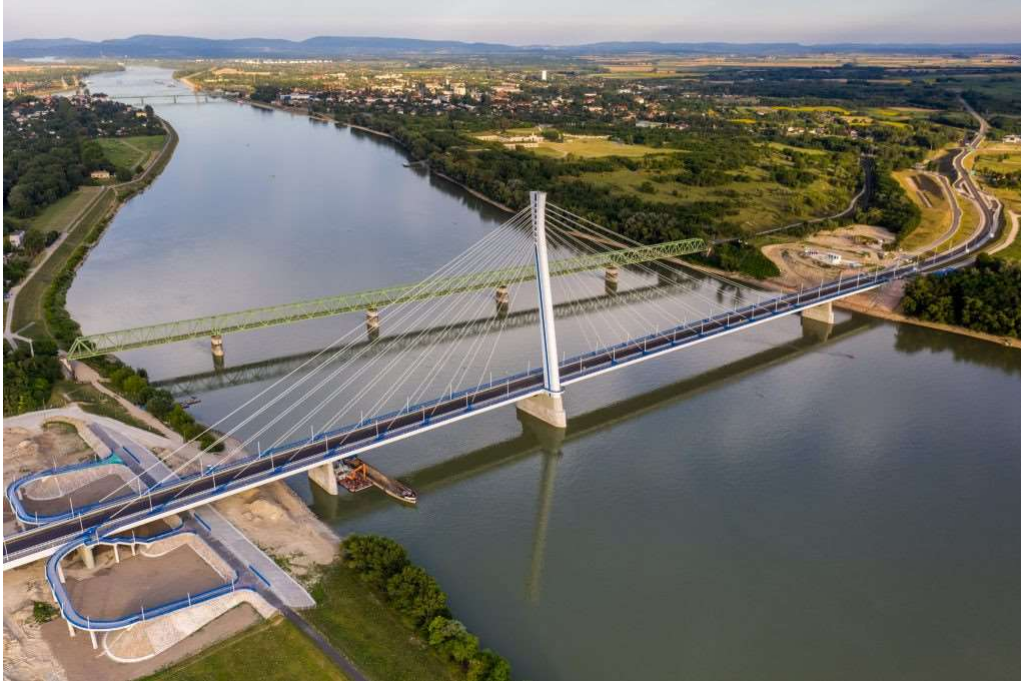
6. ábra: A dunaföldvári Duna-híd, ahonnan nemrég levették a vasutat, így a régi közösködés megszűnt, a híd csak közúti forgalmat visz.
