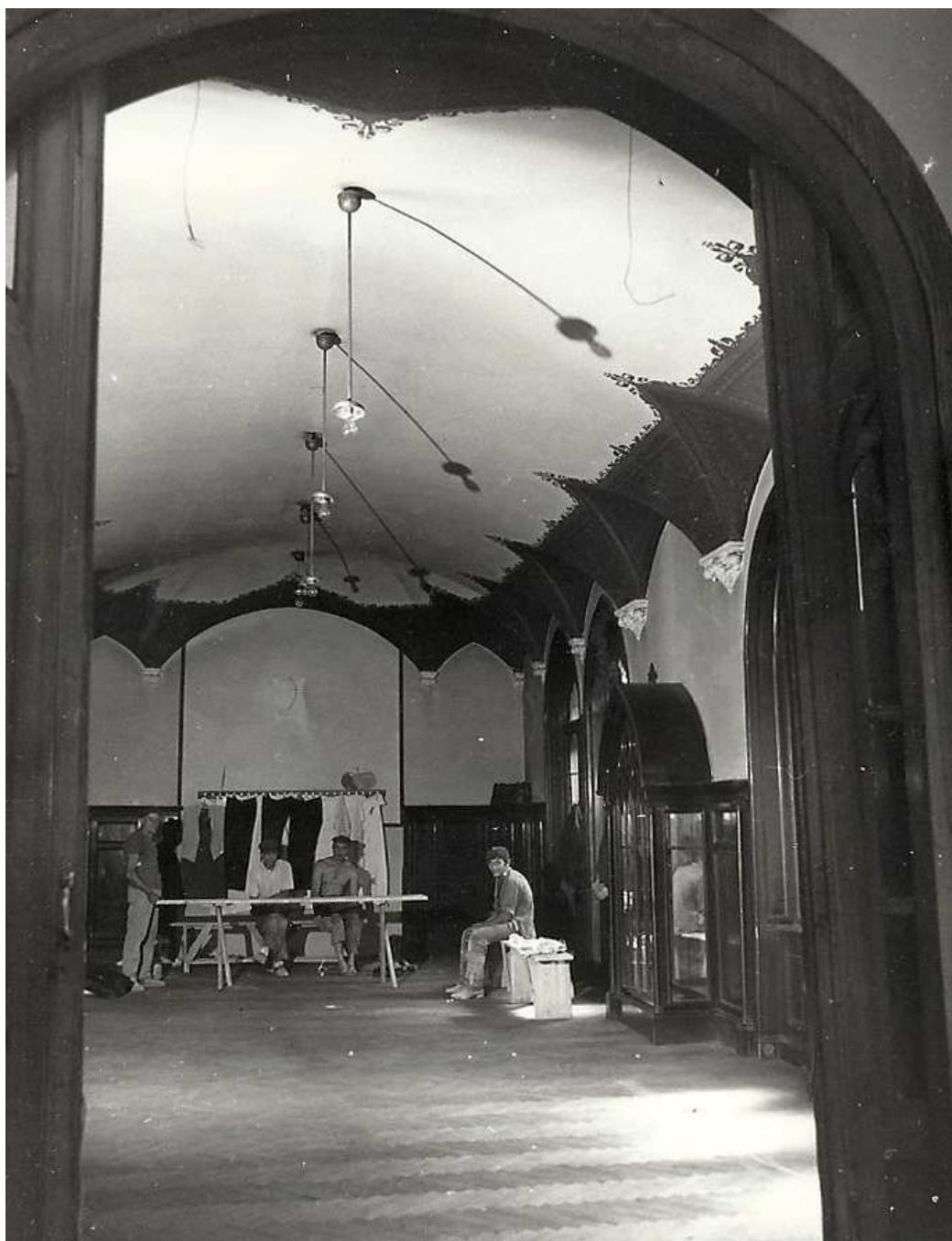
A felújítás alatti Rákóczi úti helység
